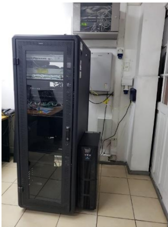
Fotos.3,- Rack con Servidores (Novuslis y Bioslis), Firewall, y equipo de comunicación internet
