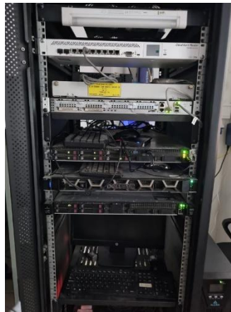
Fotos.3,- Rack con Servidores (Novuslis y Bioslis), Firewall, y equipo de comunicación internet
